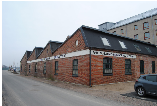
Byggnadens nordvästra samt sydvästra fasader är skyddade.
